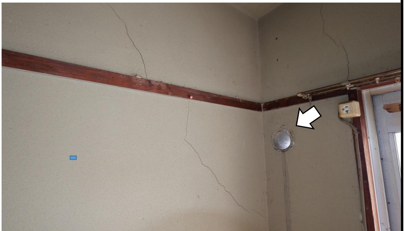
空調用の壁穴が放置され、室内への風雨の吹込みがあります。
