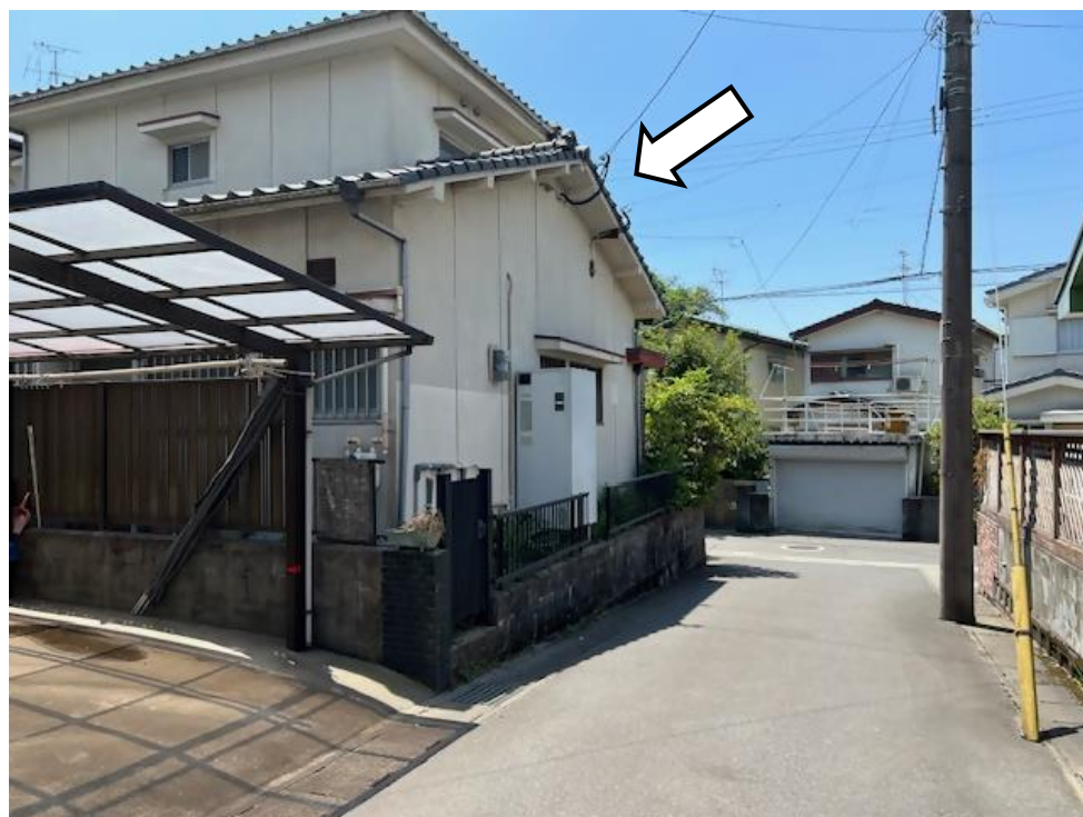
北西方から撮影
