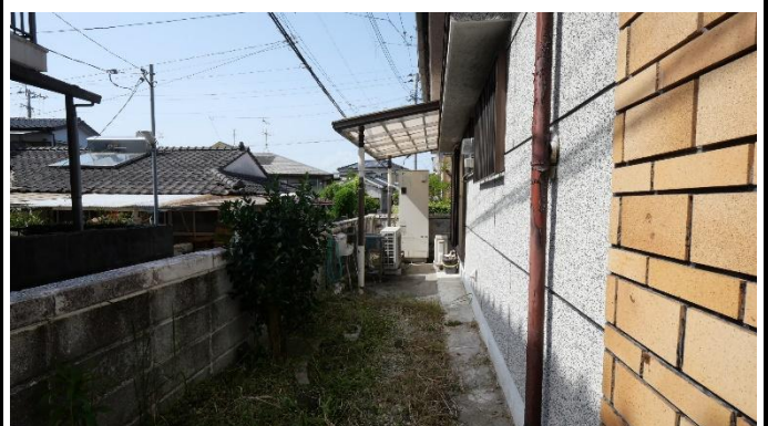
屋外（1 階西側。エコキュートあり）
