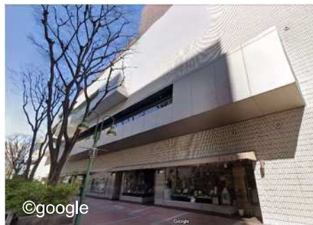
写真 6-8 単調な壁とならない工夫の例
