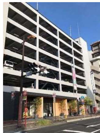
写真 6-14 1階部分を工夫した駐車場の例
