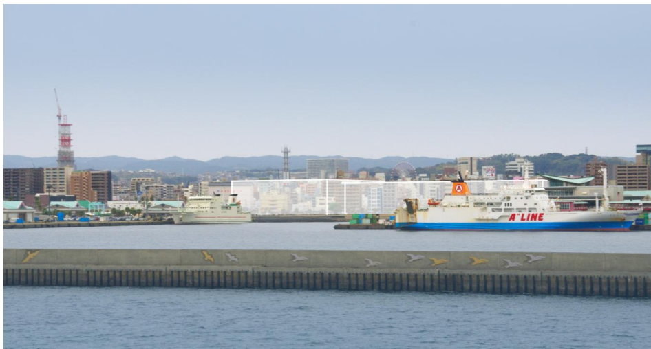
①-2_沖防波堤突端Aから（ドルフィンポート跡地等）
