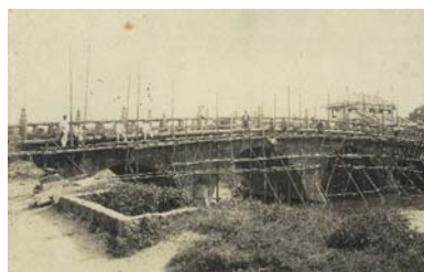
西田橋鉄管添架工事（1921年）
