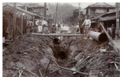
配水管布設工事（1919年柳町付近）
