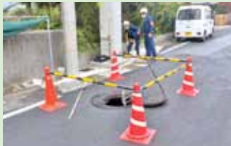
下水道施設の緊急点検訓練
