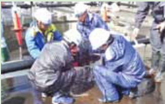
応急復旧訓練
