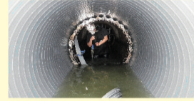
← 管更生工法による汚水管の長寿命化対策
