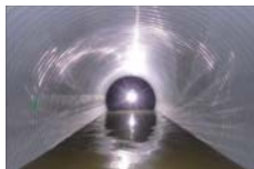
改築後の下水道管
