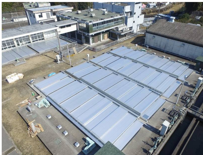
【河頭浄水場 覆蓋】
