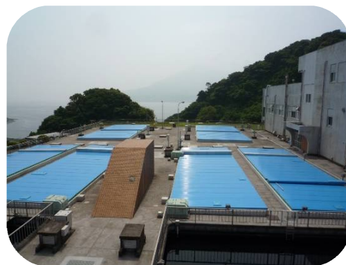
滝之神浄水場 覆蓋
