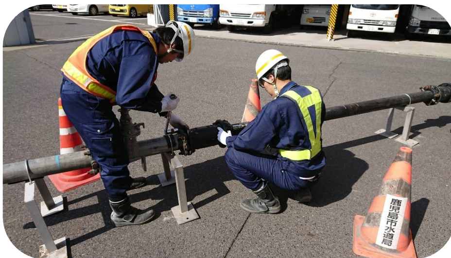
配管実技研修
