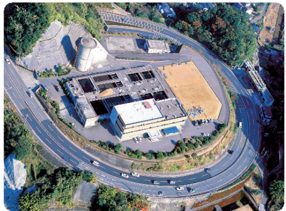
滝之神浄水場
