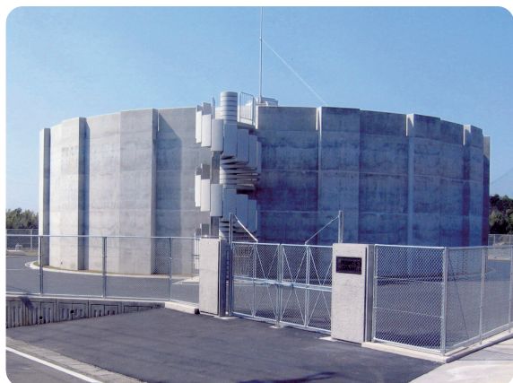
西菖蒲谷配水池
