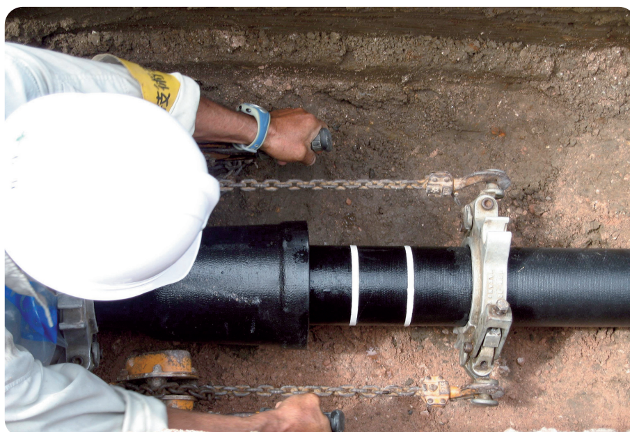
耐震管の布設
