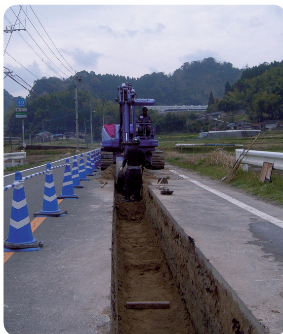
水道管の工事(道路掘削)
