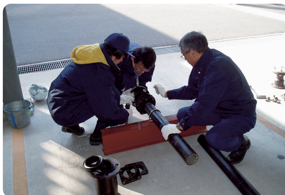
配管実技研修
